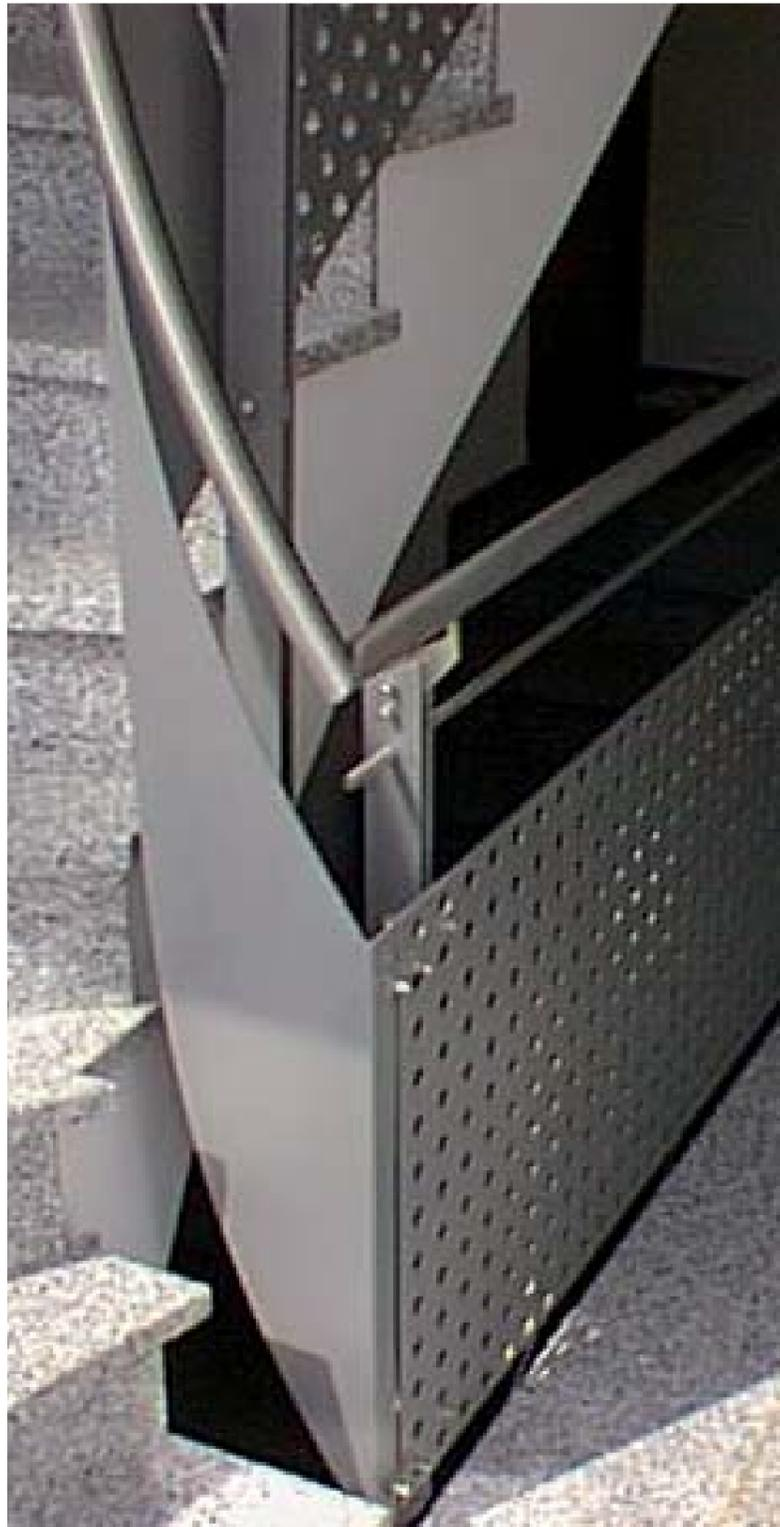
ALUMINIUMGELÄNDER, EDELSTAHLHANDLAUF UND PULVERBESCHICHTETE ALUMINIUMBLECHE
