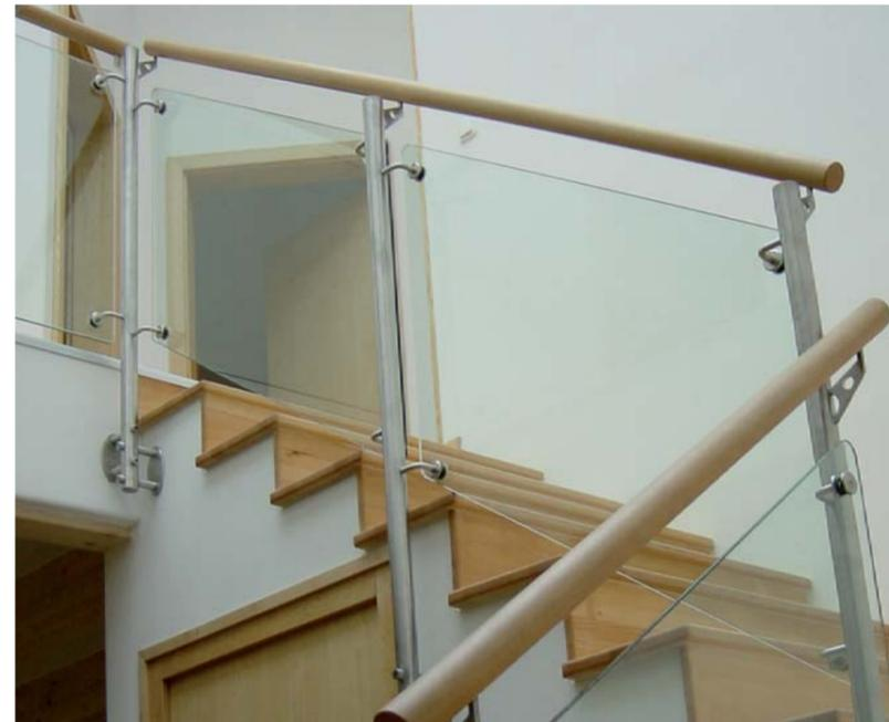
GLASELEMENTE AUS ESG KLARGLAS 10MM, PFOSTEN AUS EDELSTAHLRUNDROHR 42,4MM GESCHLIFFEN, HANDLAUF BUCHE
