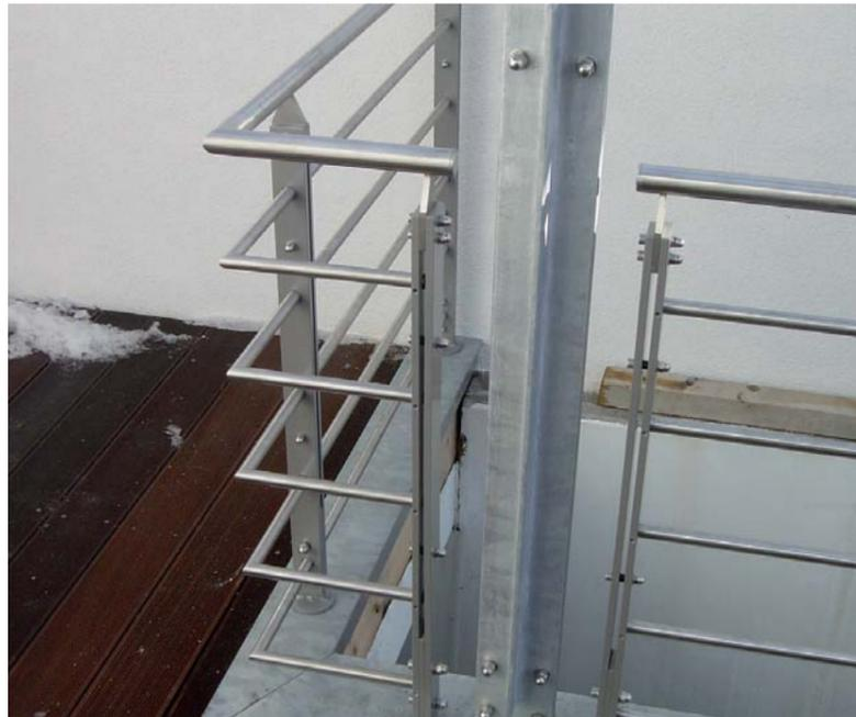
ALUMINIUMPFOSTEN GRAU PULVERBESCHICHTET MIT WAAGRECHTEN 20MM EDELSTAHLFÜLLSTÄBEN MONTIERT AUF VERZINKTER MAUERABDECKUNG
