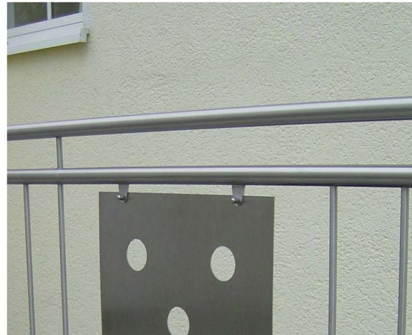
EINFACHES GELÄNDER MIT VERTIKALEN FÜLLSTÄBEN AUS 12MM VOLLMATERIAL MIT AUFGESETZTEM EDELSTAHLHANDLAUF UND LOCHBLECHELEMENTEN
