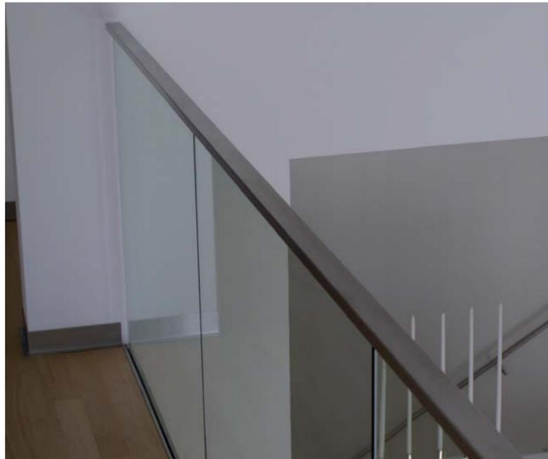
GANZGLAS-GELÄNDER BODENBÜNDIGER EINBAU DER KLEMMSCHIENE AUS EDELSTAHL, AUFGESETZTER EDELSTAHL-HANDLAUF.
