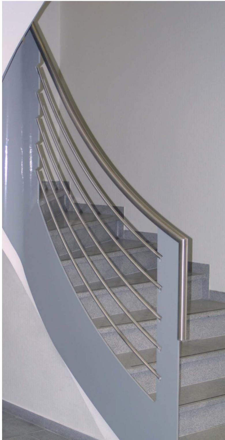
STAHLWANGENGELÄNDER SEITLICH AM BESTAND MONTIERT
