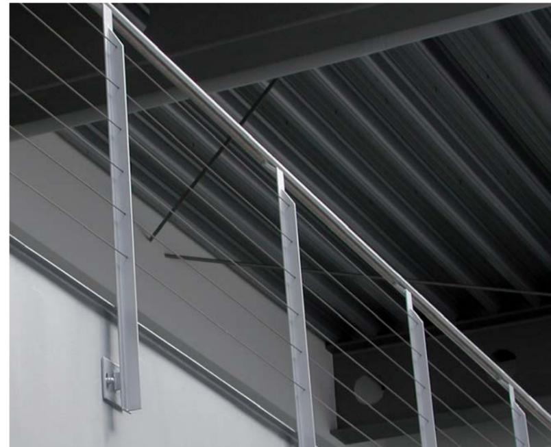
EINFACHES GELÄNDER MIT HORIZONTALER SEILFÜLLUNG AUS VERZINKTEN T-PROFILIEN MIT AUFGESETZTEM EDELSTAHLHANDLAUF. PORSCHÉ BAMBERG
