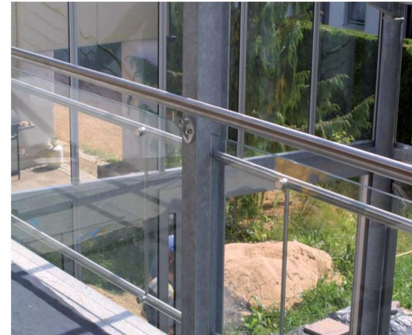
EDELSTAHL-GLASGELÄNDER, DIE SCHEIBEN SIND GEBOHRT UND PUNKTVERSCHRAUBT MIT DEM GRUNDRAHMEN AUS EDELSTAHLRUNDROHR. KOMBINATION MIT VORHANDENEM STAHLBAU.
