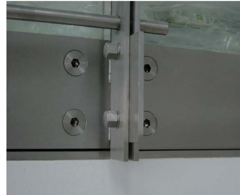
BODENBÜNDIGE EINSpanNUNG AUS EDELSTAHL GESCHLIFFEN, SÄMTLICHE SCHRAUBENKÖPFE WURDEN ÜBERDREHT.
