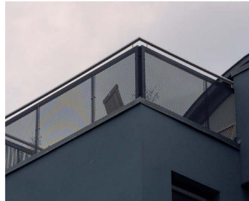
ALUMINIUMGELÄNDER AUS EINER RAHMENKONSTRUKTION UND ALUMINIUMLOCHBLECHEN QG 10-15, FÜLLELEMENTE PULVERBESCHICHTET HANDLÄUFE AUS EDELSTAHLROHR
