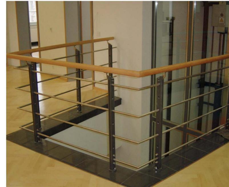
ALUMINIUMPFOSTEN MIT DURCHGEHENDEN FÜLLSTÄBEN D
